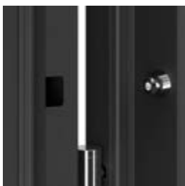
bezpečnostnější trny proti vylomení
